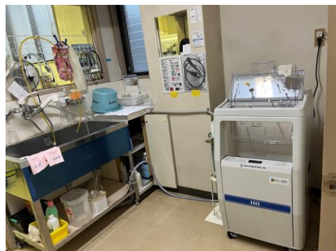
内視鏡の前洗浄向けの広いシンクが設置されている。シンクでの前洗浄後、OEDでの洗浄消毒を実施している。
